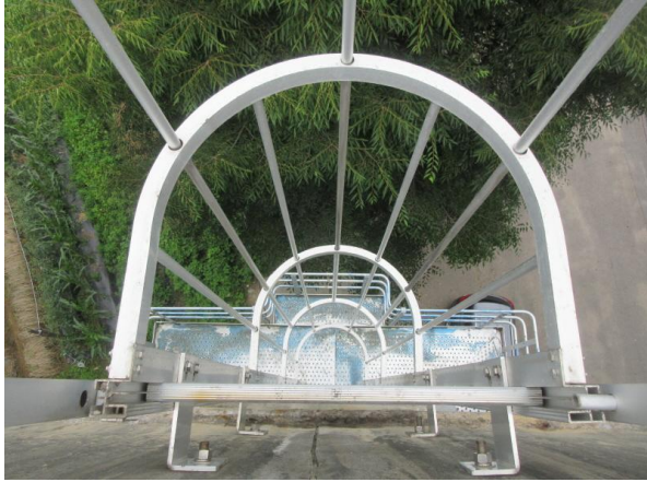
점검사다리 상태양호 P2
