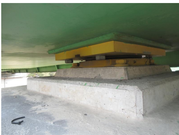
받침장치 상태양호 P2-SH2
