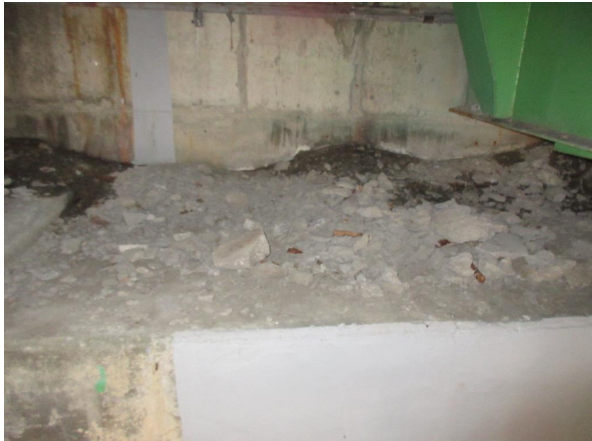
교대 페콘크리트 적치 A2
